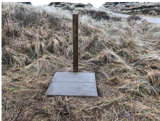
Fliser lagt, stolpe nedgravet
